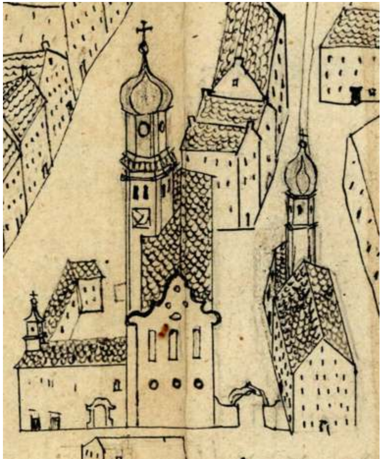
Das neben der Stadtpfarrkirche auf dem heutigen Kirchplatz gelegene alte Spitalgebäude samt Spitalkirche (Ansicht aus der Zeit um 1700)
